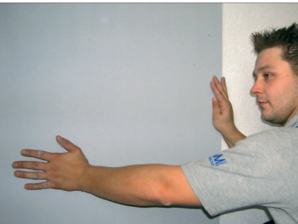
Ankleben der Calcium-Silikatplatten. (Fotos: Casiplus)
