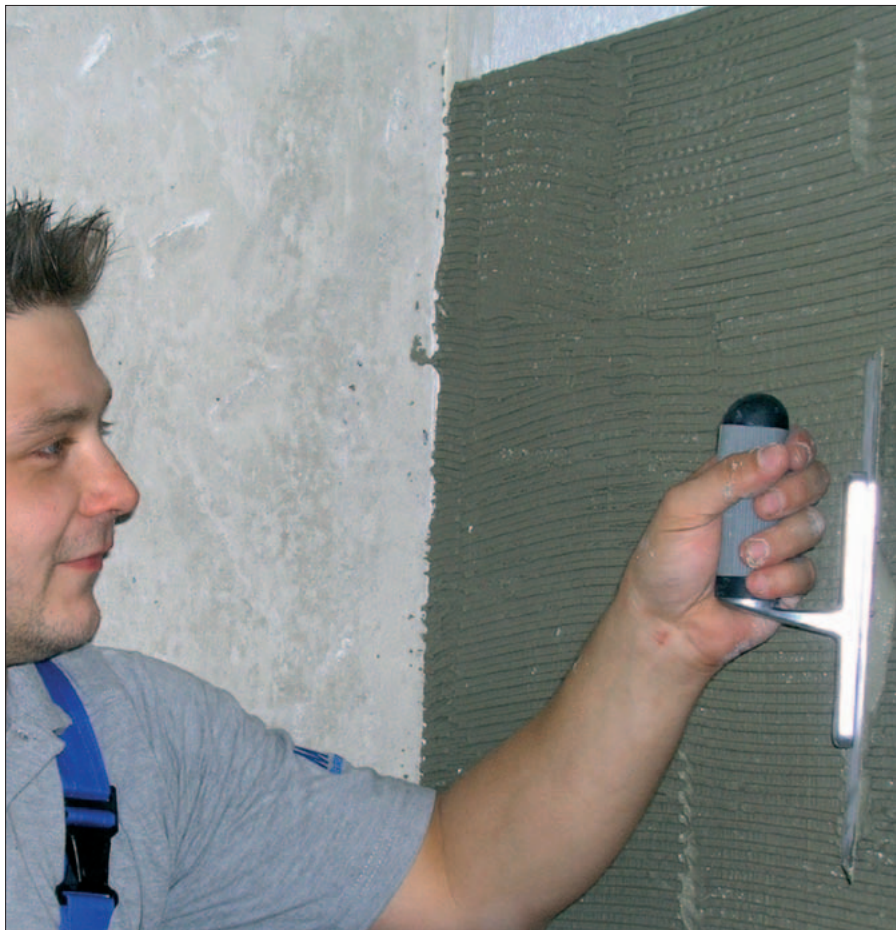
Vollflächige Verklebung der Platten mit Zahnpachtel.
