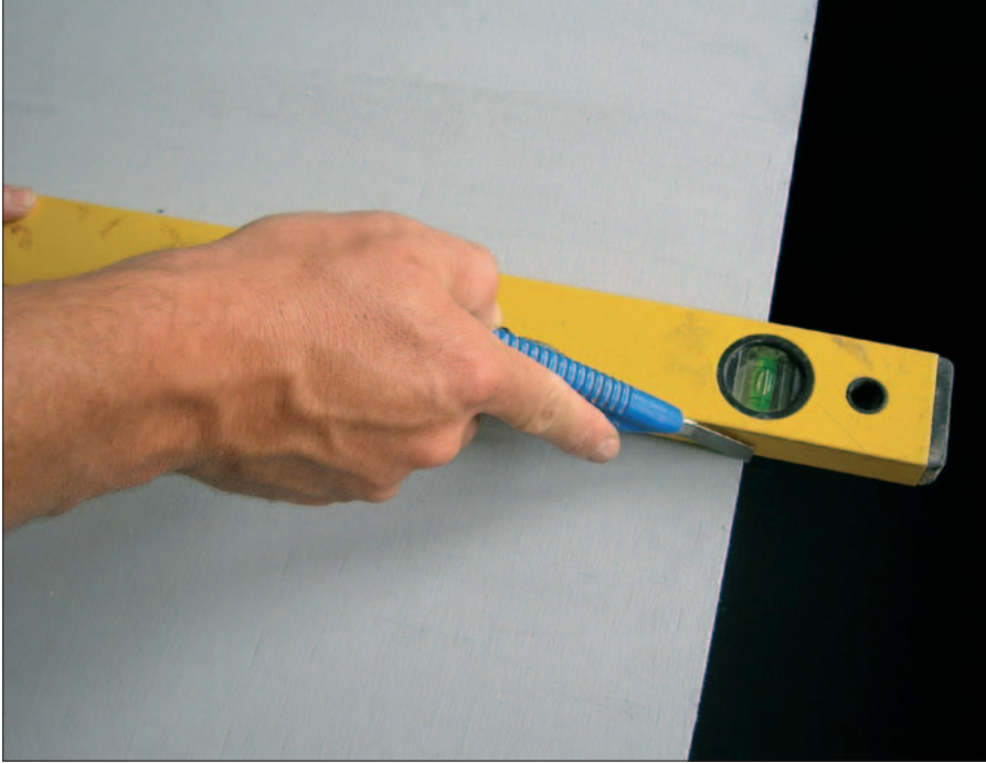
Schneiden der Calcium-Silikatplatten.
